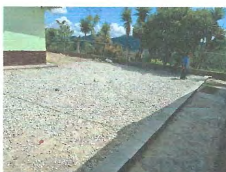
Foto 4: Espacio suficiente para elaborar una galera de 6x6.
