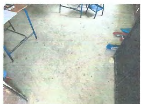
Foto 6: Espacio adecuado para colocar piso de granito.
